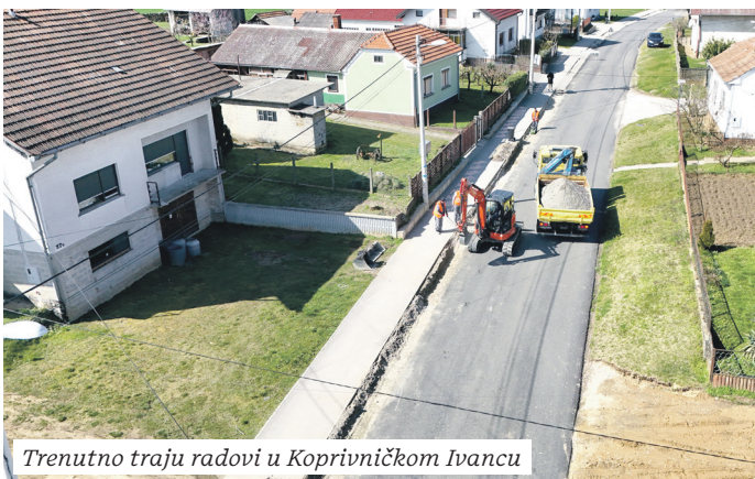
U Vinogradskoj se ulici proširuje kolnik te se postavljaju rubnici
