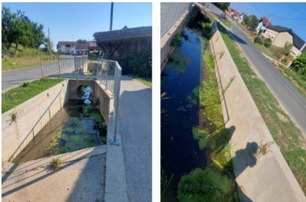
Slika 1.1.1.2. Nastavak trase potoka Mucinjek - pogled na zacjevljeni dio trase uz ŽC2081
