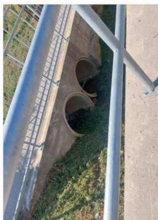
Slika 1.1.1.9 Detalji propusta ispod ŽC2081
