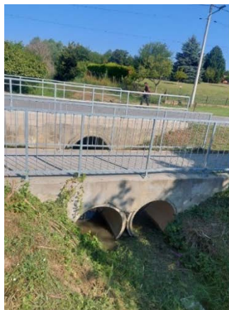
Slika 1.1.1.8. Prolaz potoka na ŽC2081 - uzvodno prirodno obrasli pokosi potoka te nizvodno cijevni propust
