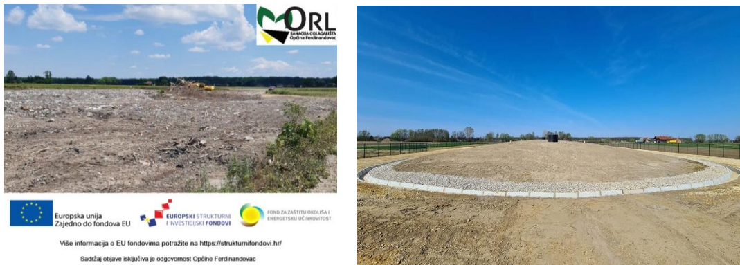
Slika 11: Odlagalište otpada Ferdinandovac, sanacija u tijeku i nakon sanacije (Izvor: https://www.ferdinandovac.hr/index.php/opcina-ferdinandovac/orl-projekt )
