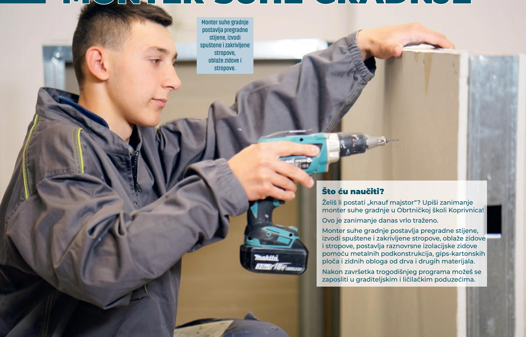
Monter suhe gradnje postavlja pregradne stijene, izvodi spuštene i zakriviljene stropove, oblaže zidove i stropove.
